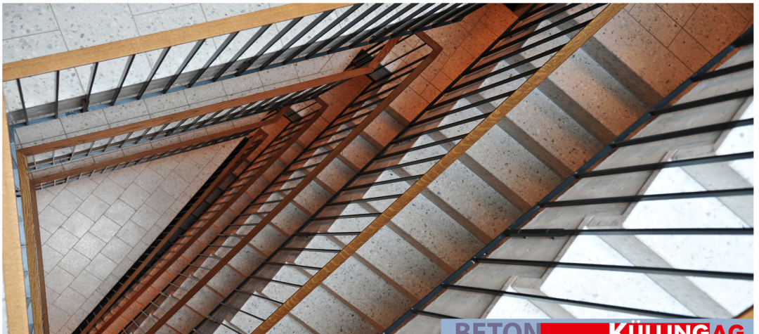
Zürich, Wohnhaus Uetlibergstrasse: zweifarbige Bodenbeläge & Treppen
